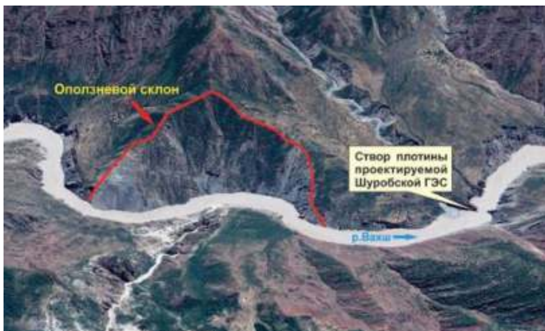
Рис 5. Оползневой склон в верхнем бьефе проектируемой Шуробской ГЭС (Космоснимок из Google Earth от 7.07.2017г.).
